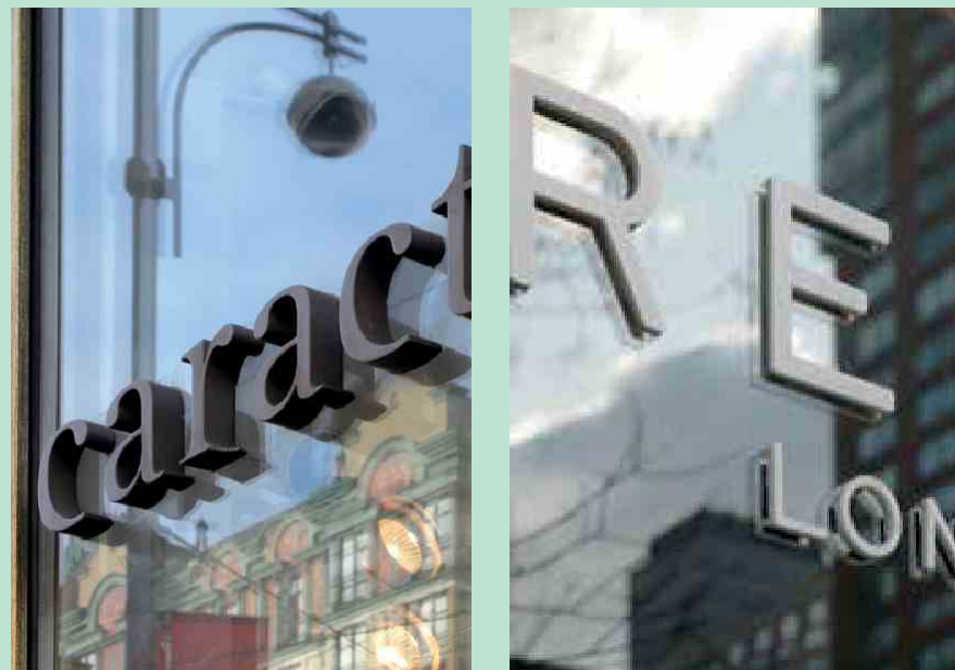
Объёмные буквы и знаки, установленные на стекле
